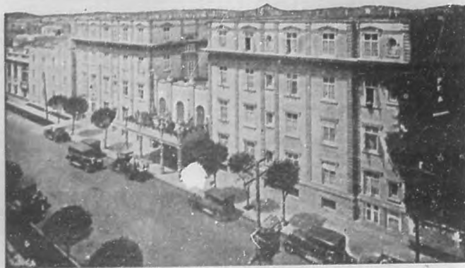
FACHADA DEL HOTEL
